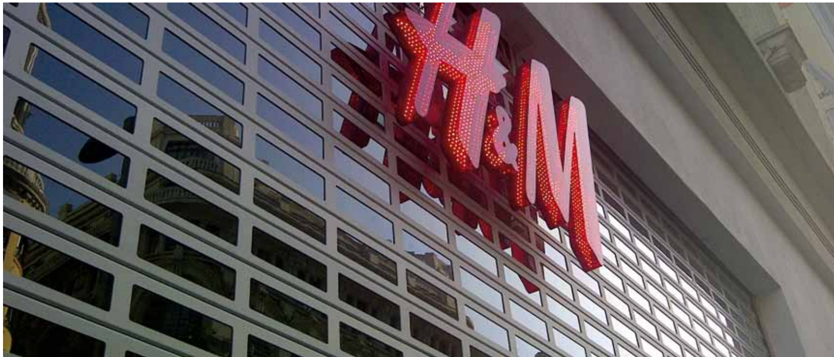
Mod. SATEN (Ajouré + lame de polycarbonate) en finition anodisé Argent Mat.
